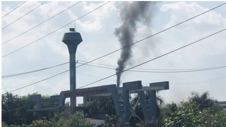
Nhà máy đốt rác
